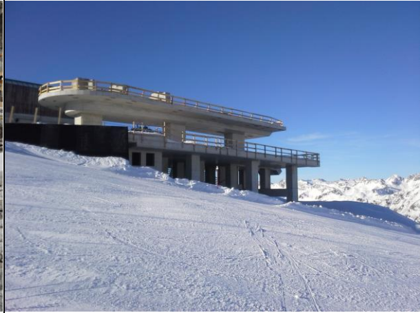
混凝土结构竣工
