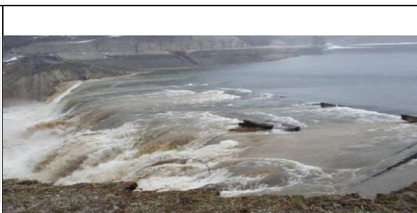
地震造成滕沼大坝溃坝
