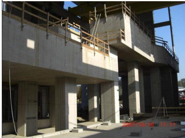
机组地基完工
