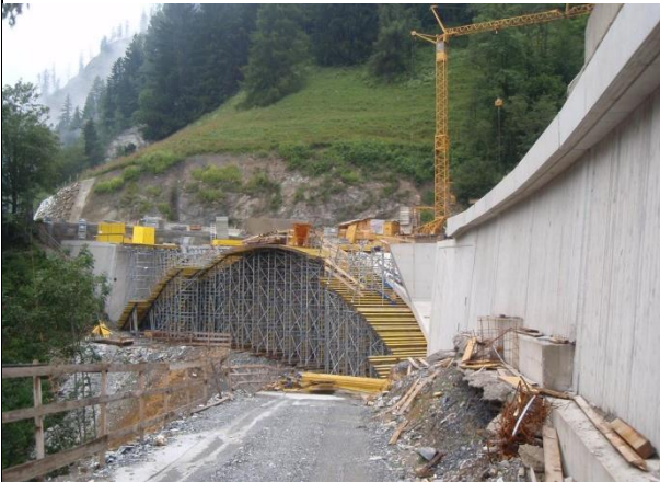
建设中的大桥
