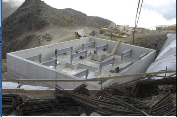
3 号支架: 建在永冻层上的支架箱式地基
