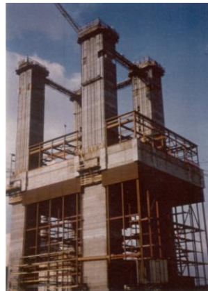
为西门子奥地利公司进行的总体设计 将一万吨重的支架提升至 76 米的高度
