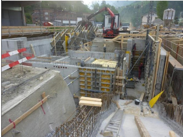
建设期间，火车照常通行
