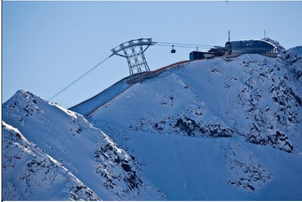
建在永冻层上的 3 号支架和山顶站
