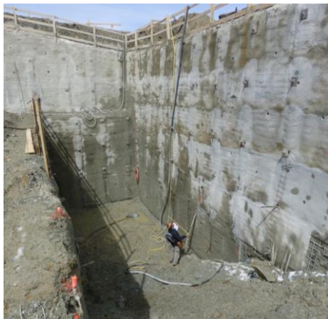
山顶站地基挖掘和加固过程中永冻层开始溶化
