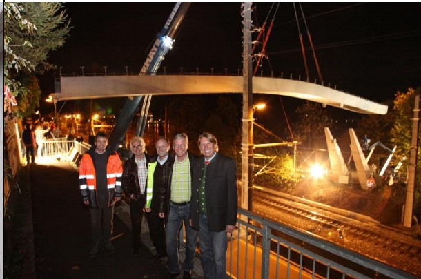
横跨铁道的赫尔顿海茵桥
