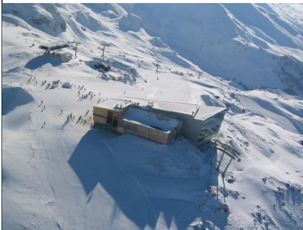
新山顶站和 3S 缆车 5 号支架
