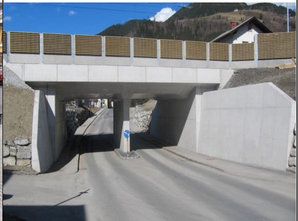
公路地下通道
