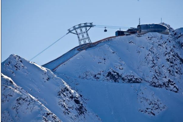
Stütze 3 und Bergstation
