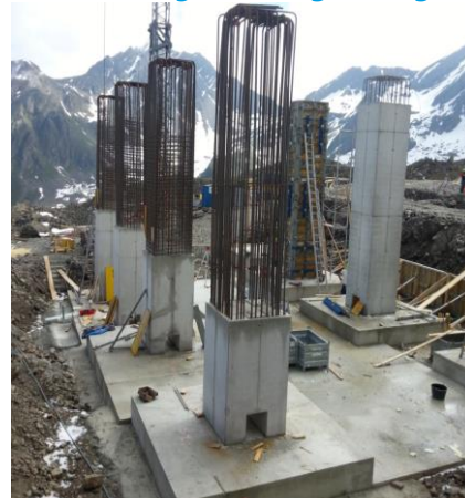
Einzelfundamente und Hubstützen
