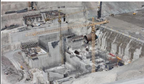
Detailausschnitt während des Baus
