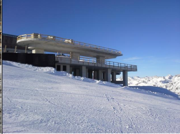
Betonstruktur fertig gestellt
