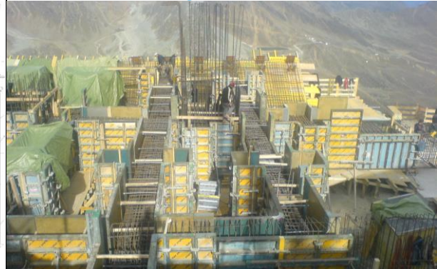
Bergstation: Trägerrost unter der Stationskonstruktion
