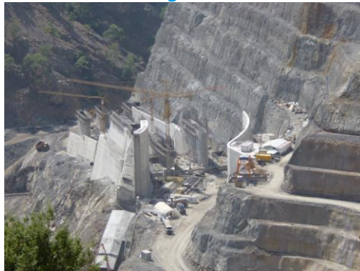
Detailausschnitt während des Baus
