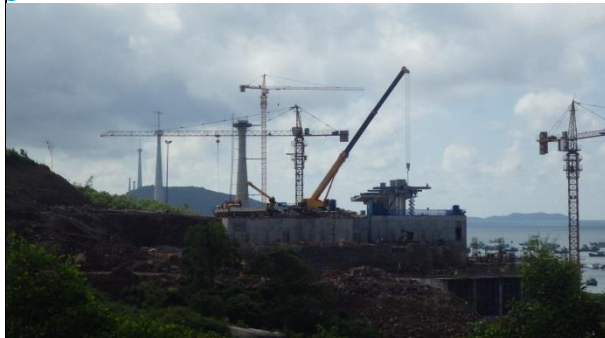
3 der höchsten Seilbahnstützen weltweit
