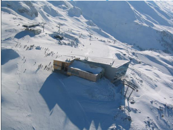
Bereich der neuen Bergstation und Stütze 5 für die 3S-Seilbahn
