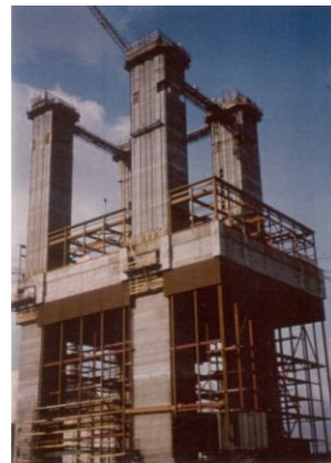
Gesamte Planung für Siemens Österreich Heben des Kopftragwerkes (10.000 tons) bis auf eine Höhe von 76m
