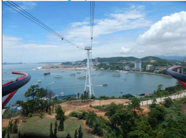
Ansicht von der Bergstation zur Talstation
