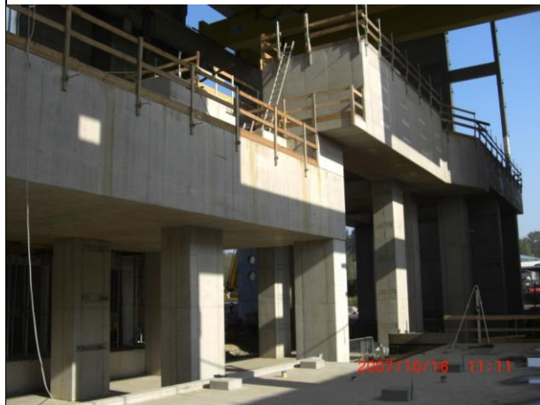
Gesamtes Turbinenfundament fertig
