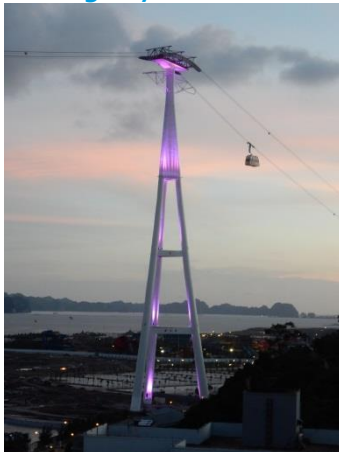
Höchste Seilbahnstütze der Welt dzt. 188,88m!
