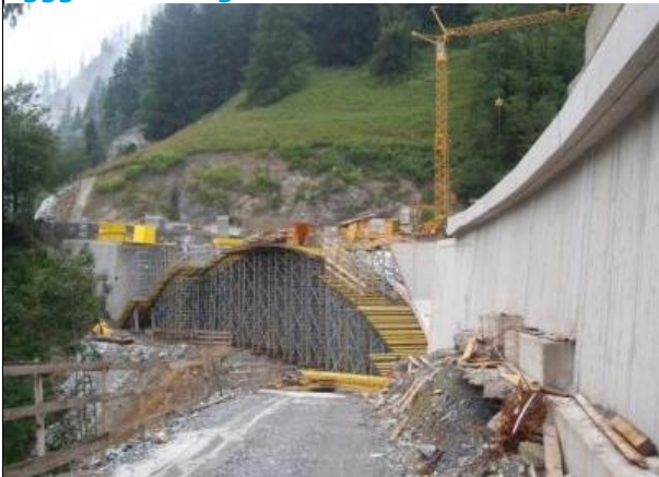
สะพานอยู่ระหว่างการก่อสร้าง
