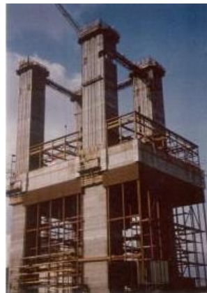
การออกแบบที่สมบูรณ์ในนามของ Siemens Austria ยกโครงหัว (10,000 ตัน) ได้สูงถึง 76 เมตร
