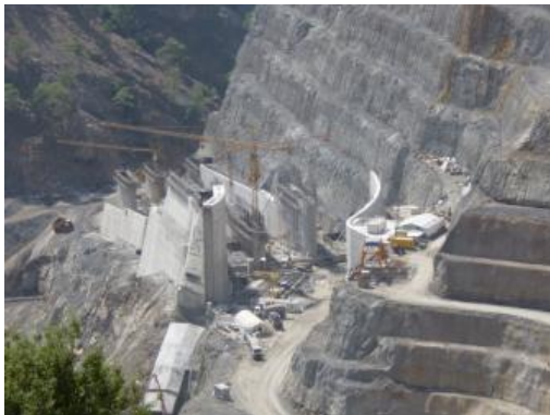
รายละเอียดระหว่างการก่อสร้าง
