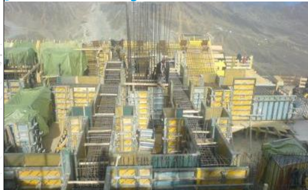
สถานีบนสุด: คานมัดอยู่ระหว่างการก่อสร้าง
