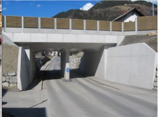
ทางลอดถนน
