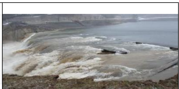
เขื่อนแตก เขื่อน Fujinuma จากการเกิดของแผ่นดินไหว
