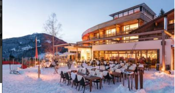
โรงแรมที่เสร็จสมบูรณ์ในโครงสร้างไม้
