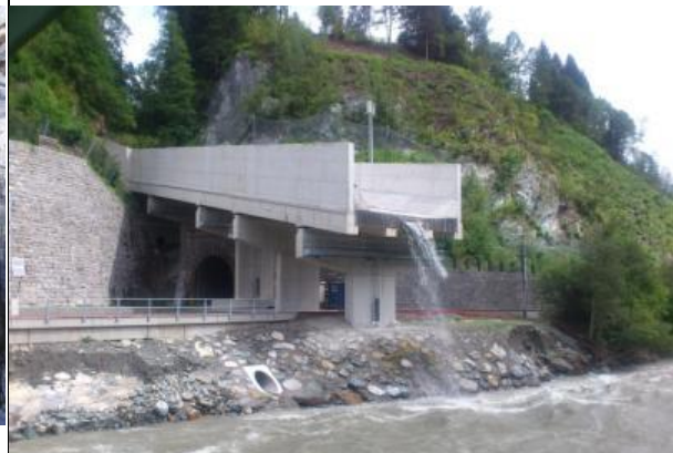
ระบายโคลนล้นทางรถไฟลงสู่แม่น้ำ
