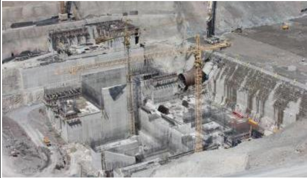
รายละเอียดระหว่างการก่อสร้าง
