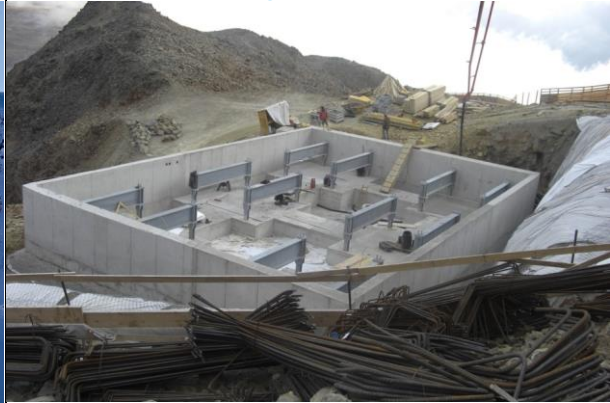
Stütze 3: Wannenkonstruktion für das Fundament der Stütze auf Permafrost
