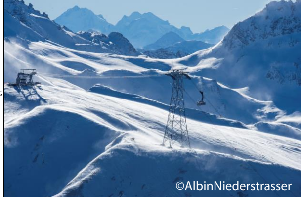
Stütze 2 und Bergstation auf Permafrost
