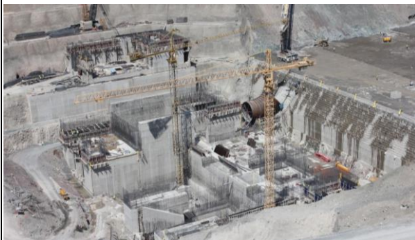
Detailausschnitt während des Baus
