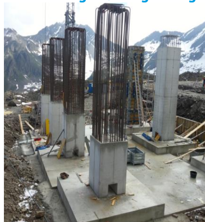
Einzelfundamente und Hebestützen
