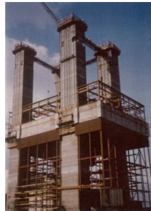
Gesamte Planung für Siemens Österreich Heben des Kopftragwerkes (10.000 Tonnen) bis auf eine Höhe von 76m
