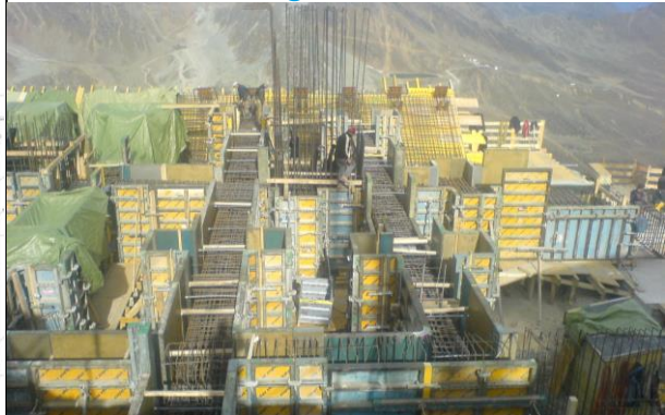
Bergstation: Trägerrost unter der Stationskonstruktion
