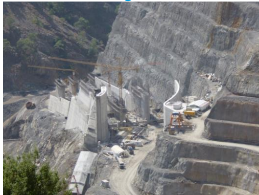
Detailausschnitt während des Baus
