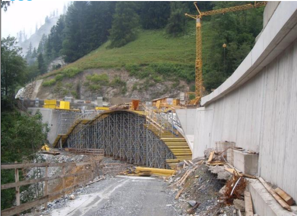
Brücke während des Baus
