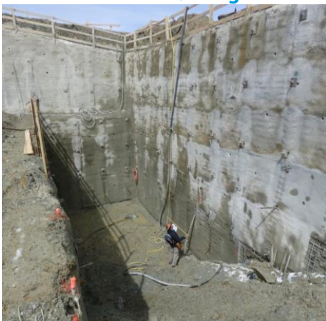
Bergstation: Permafrost taut auf während des Aushebens und der Verankerungsarbeiten
