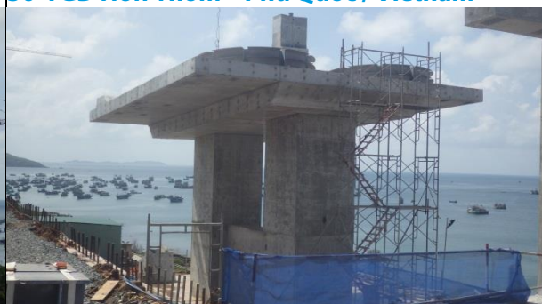
Antriebsstation direct am Meer
