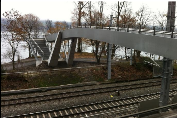
Fertig gestellte Brücke
