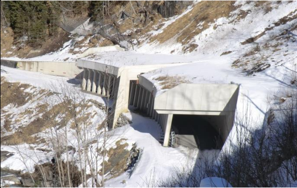
Galerie zum Schutz gegen Lawinen, Muren und Steinschlag
