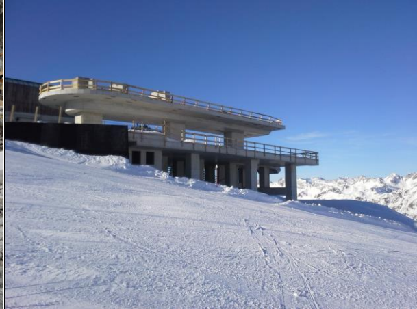
Betonstruktur fertig gestellt
