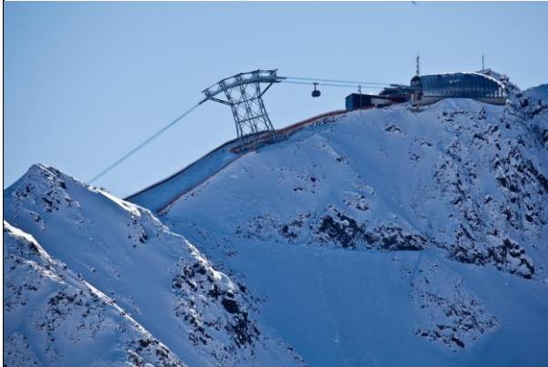
Stütze 3 und Bergstation auf Permafrost
