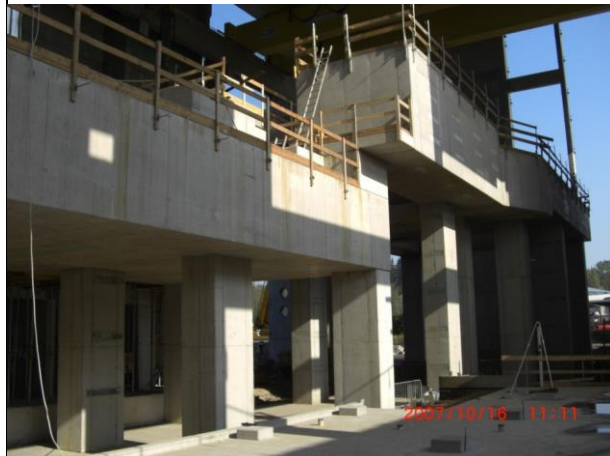
Gesamtes Turbinenfundament fertig
