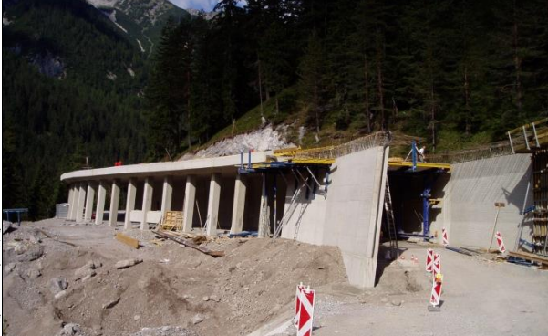
Lawinenschutzgalerie für Straße und Gehsteig
