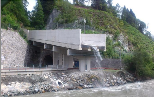
Galerie gegen Muren über die Eisenbahn zum Abfluss in den Fluss Salzach
