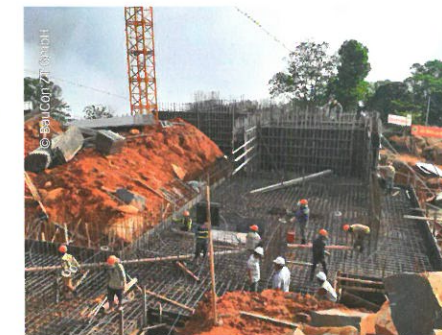
Bewehrungsarbeiten an der Kellerdecke des Museums
