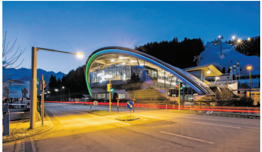
Die Talstation des neuen „areitXpress“ ist eine echte Sehenswürdigkeit. Für die Holzgitterkonstruktion der Station wurden insgesamt 300 m 3 Holzleimbinder verbaut, wobei der längste durchgehende Binder – der Bogen – 70 Meter lang ist. Einzigartig ist auch der Einsatz einer über 2000 m 2 großen Membrane, die das Gebäude wie ein Schirm überspannt. BILD: SNS/SCHMITTENHÖHEBAHN AG
