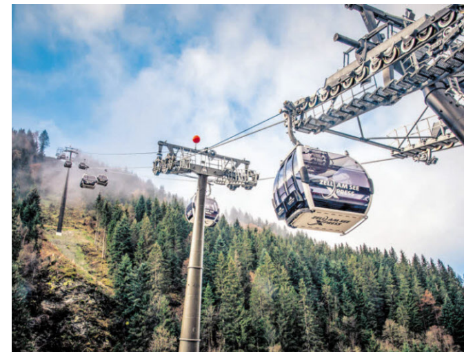
Die Errichtung der Sektion I des zellamseeXpress brachte so manche Herausforderung mit sich.
