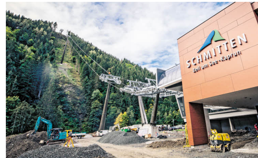
Die Bauarbeiten des zellamseeXpress in Viehhofen starteten mit Ende der Wintersaison 2018/2019 planmäßig in die zweite Bauphase.
