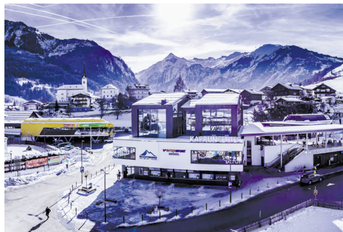
Das Kaprun Center vereint die Talstation der MK Maiskogel, Kassen, die Unternehmenszentrale sowie ein modernes Skidepot und einen Bründl Sports Sport- & Rentshop unter einem Dach. BILD: SN/GLETSCHERBAHNEN KAPRUN AG (2)
