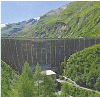
Geplant: Erhöhung der Limbergsperrre um das Stauziel des Speichers Wasserfallboden um 8 m zu erhöhen.
